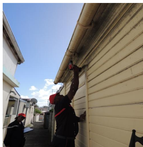
Fig. 18 : percement d'une gouttière constituant un gîte larvaire
